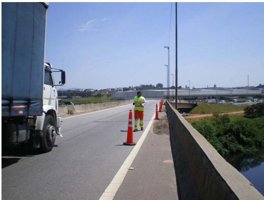
Figura 19 - Posicionamento dos cones para a formação da área de transição. Fonte: Autor, 2013.
