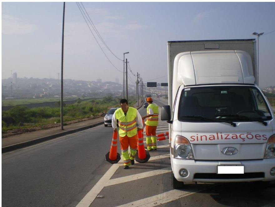
Figura 14 - Posicionamento do veículo em local onde não há acostamento. Fonte: Autor, 2013
