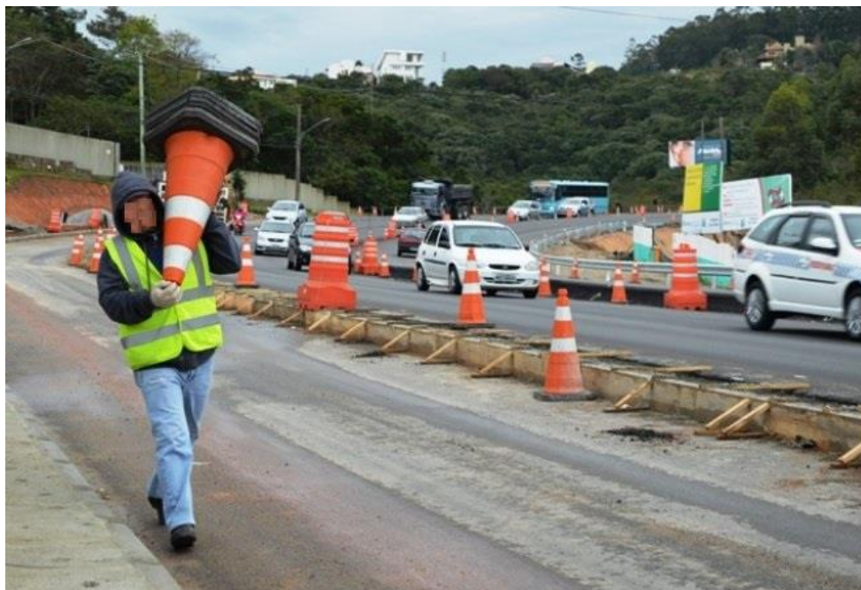
Figura 16 - Posicionamento dos cones. Fonte: www.tudosobrefloripa.com.br , 2013
